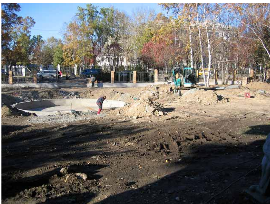
工事中の前庭
