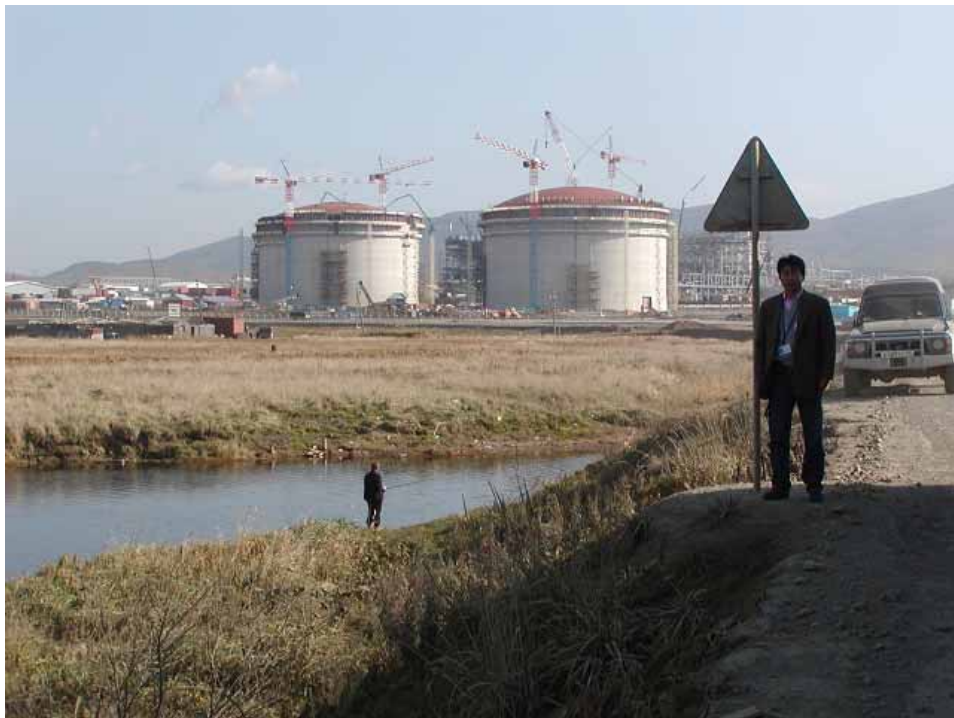
コンクリートが巻き立てられた貯蔵タンク (撮影日 2005年10月20日)
