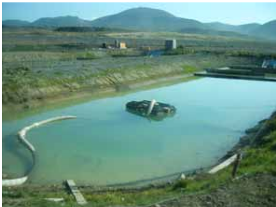
雨水処理用の沈殿地
